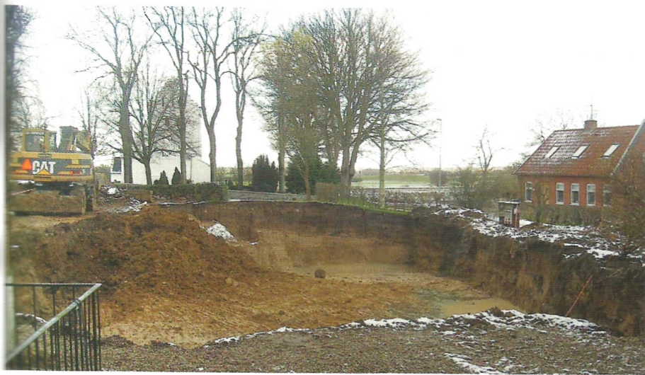
Et historisk billede fra januar 2006. Hullet er gravet til sandpudedefunderingen.
